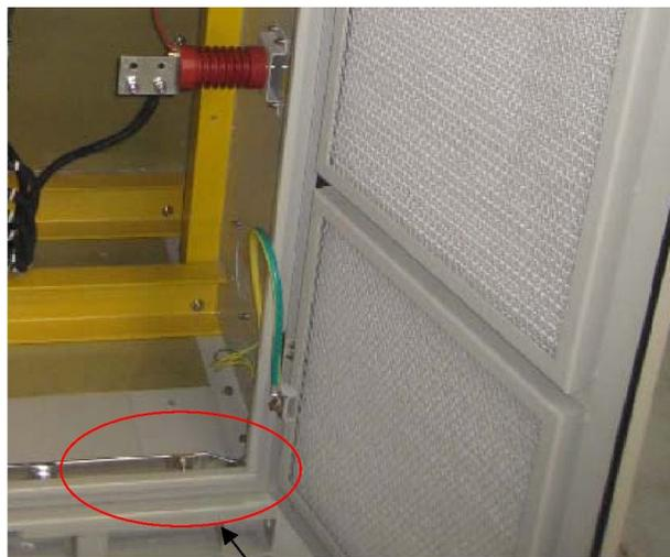
Рисунок 2.8. Расположение точки заземления экранирующего слоя высоковольтного выхода
