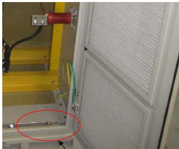
Рисунок 2.8. Расположение точки заземления экранирующего слоя высоковольтного выхода
