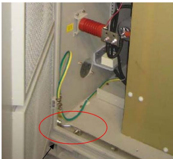
Рисунок 2.7. Расположение точки заземления экранирующего слоя высоковольтного входа
